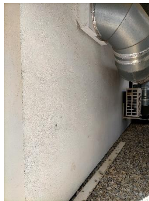
Figura 5 Zona equips elèctrics
