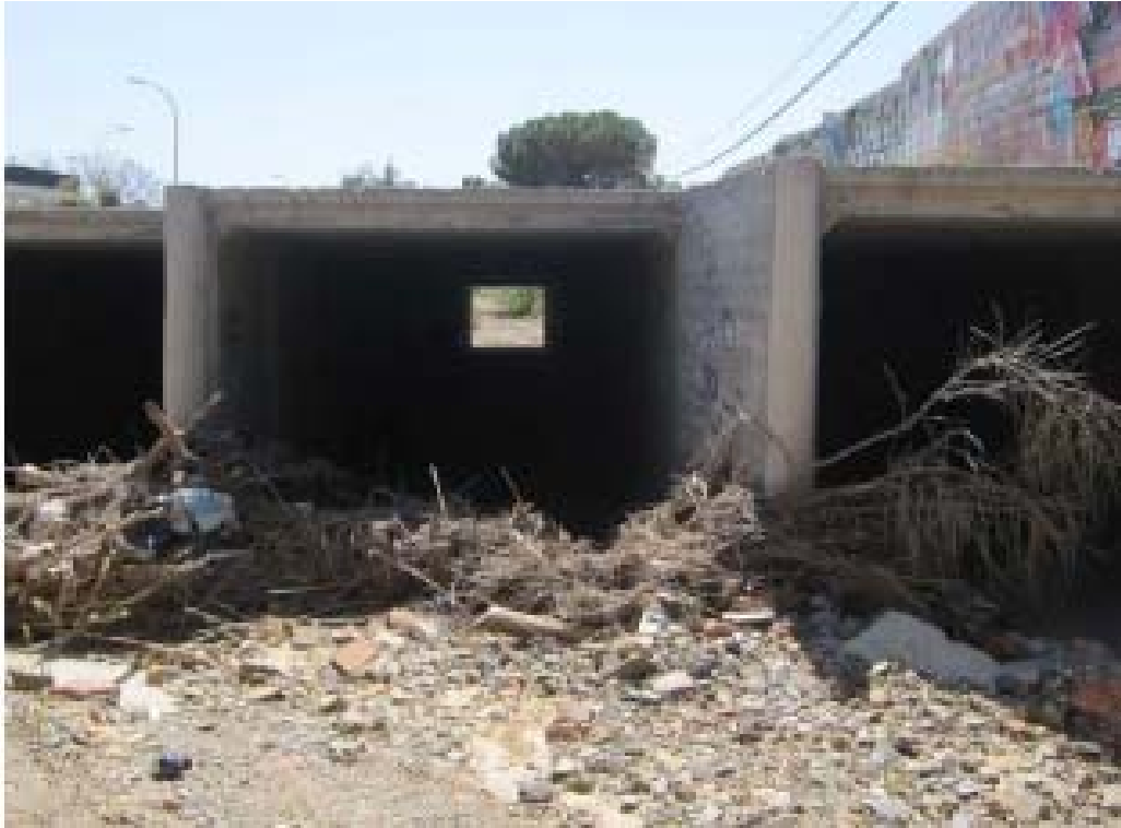
Obra de drenatge sota futura rotonda. Aigües avall obra drenatge sota N-420
