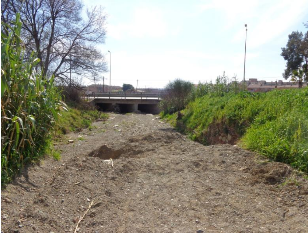
Obra de drenatge sota Crta. N-420
