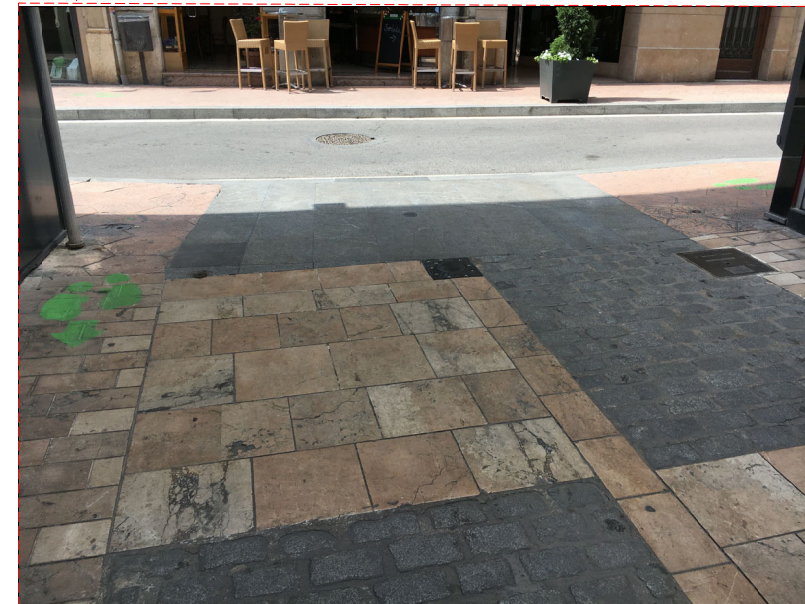
PATRÓ PAVIMENTACIÓ EXISTENT -INTERSECCIÓ CARRER DEL VIDRE-
