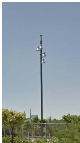
Columna zona petanques
