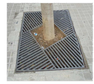
Escocell de fosa, dues peces format perfils de 40x10 mm cada 40 mm (forat de 30 mm) Sobre marc format per L fosa de secció 50x10mm amb dimensions perimetrals de 1330x980mm
